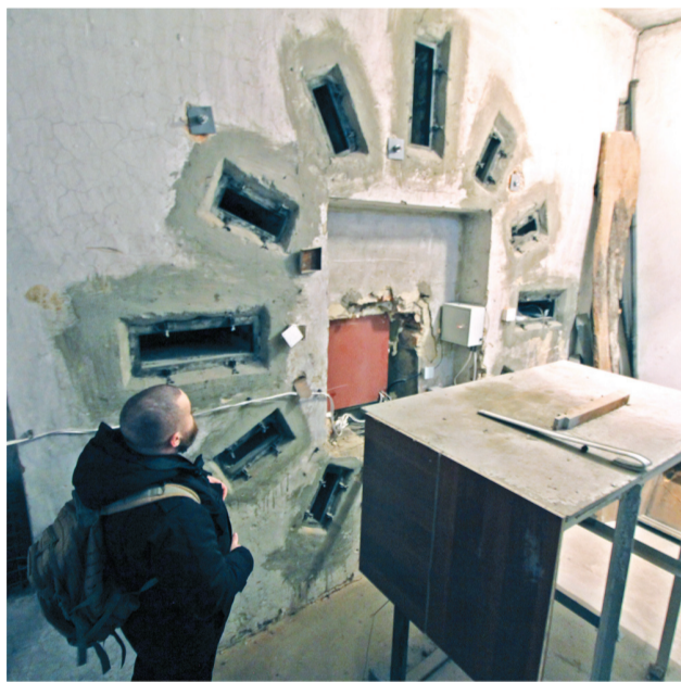
Раньше механизм вокзальных часов занимал почти целую комнату.
